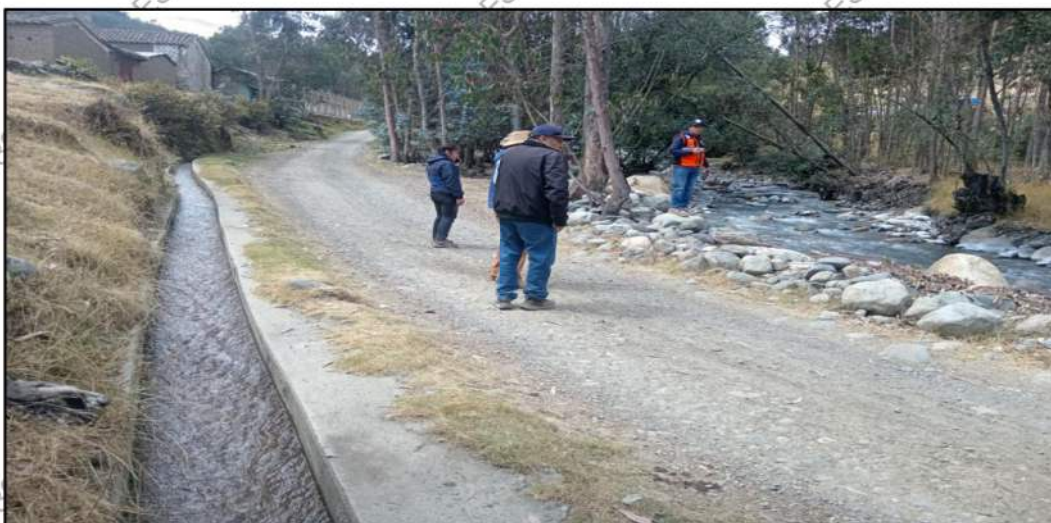
FOTOGRAFÍA N° 03: TRAMO CRÍTICO IDENTIFICADO EN LA QUEBRADA PARIAC, SECTOR MACASHCA, SE OBSERVA EROSIÓN, ESPECÍFICAMENTE EN EL MARGEN IZQUIERDA.
